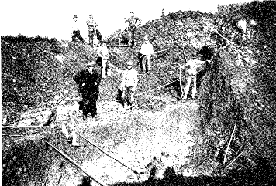
Terrassement de la casemate Ottange - Centre
