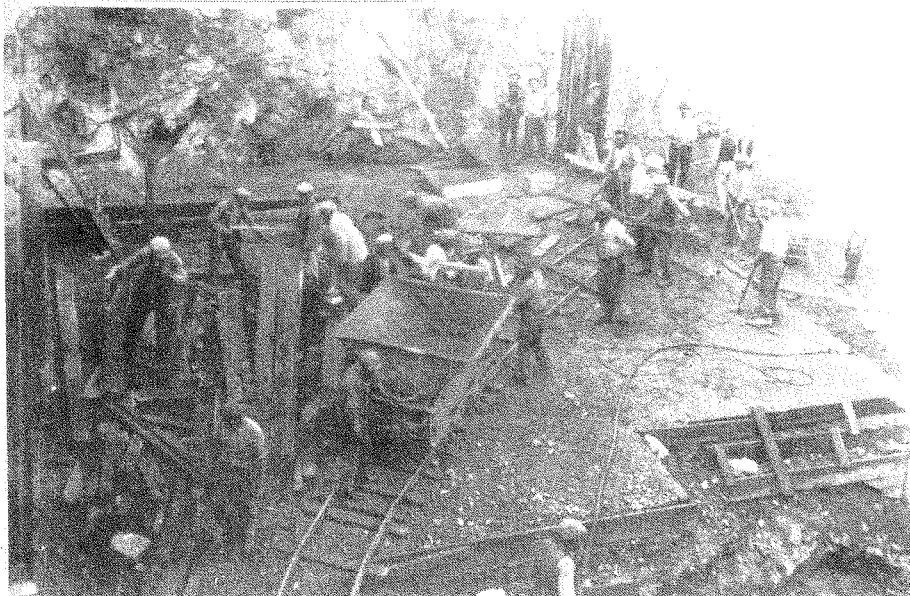
Ouvrage en cours de construction
