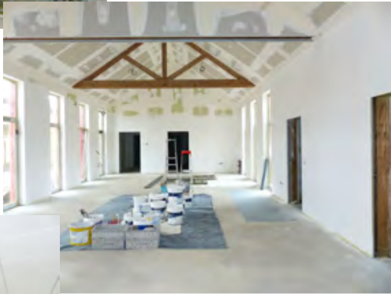
Isolation extérieure et placage-enduit intérieur
