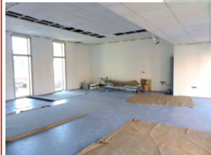
Pose des revêtements de sol
