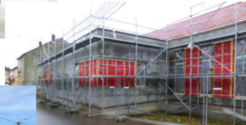
Réalisation du grésé façade et pose des faux-plafonds
