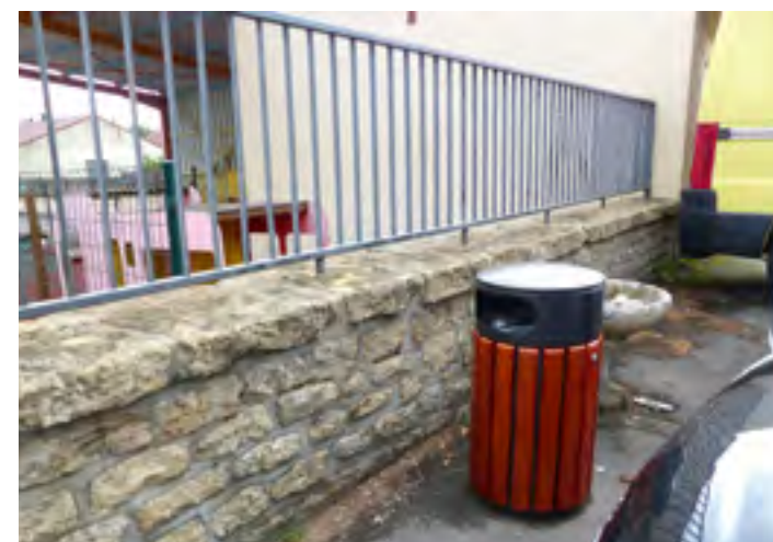
Derrière le Multi-Accueil
